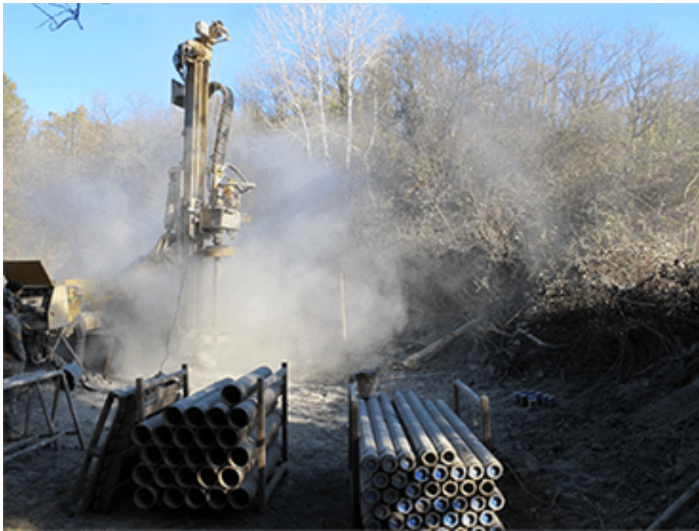
Le forage dégage un panache de poussière d'argile © V. Bertrand, Eost/Résif
