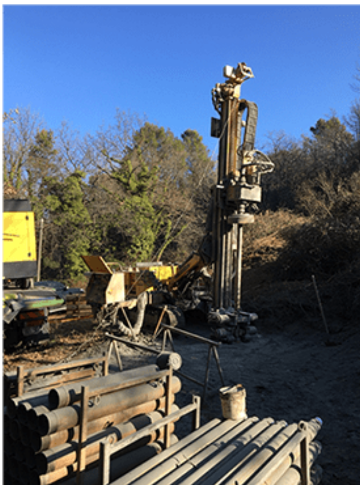
La foreuse est en place. Au premier plan, les tubes de carottage attendent d'être assemblés au fur et à mesure de la percée. © J.P. Ampuero, Géoazur
